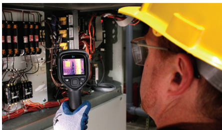
透過紅外線熱影像，快速了解建築牆壁隔熱材或漏水等問題。
